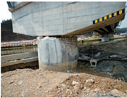
写真-1 津波により被災した国道45号線の歌津橋
