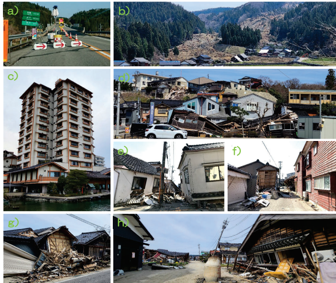
a) 能越自動車道、b) 土砂崩れ、c) 加賀屋旅館（RC 壁のせん断ひび割れ）、d) 写真奥は法面（のりめん）の崩壊。写真手前は平屋木造住宅の倒壊、e) 『ねじれ』による 2 階建木造住宅の層間崩壊、f) 筋交い不足による層間崩壊、g) 地震と津波襲来後の木造家屋群の様子、h) マンホールが地盤の液状化により 150 cm 上昇、写真の左右で木造住宅の損傷状況が異なる。右は旧耐震基準で設計された建物、左は被災後も自立しているため新耐震設計法施行後の建物と推察される。
