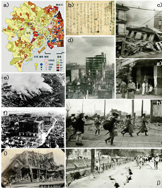
a) 人的被害の要因、b) 翌日の電報『東京市全滅』、c) 木造建築の倒壊と火災（日比谷）、d) 鎮火後の銀座付近、e) 9 月 2 日の都心部（延焼の様子）、f) 帝国ホテル（鉄筋コンクリート構造）周辺の様子、g) 帝国ホテル入口（避難拠点として活躍）、h) 子供を背負って非難する兵士、i) 丸善（鉄骨造）の崩壊、j) 地割れの様子。【出典】朝日新聞デジタル、歴史地震研究会・日本地図センター、金山弘昌：関東大震災と日本橋の近代建築（日本橋研究）、USGS Denver Library Photographic Collection, 1923.
