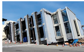
横倒れた 7 階建て鉄筋コンクリート造建物
