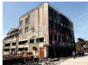
4 階建て鉄筋コンクリート造商業施設
