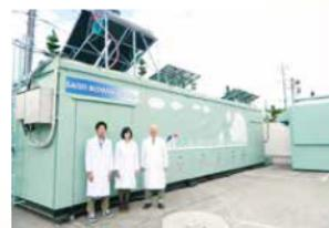
にエンジンを動かし発電する仕組みで、その処理能力は1ヶ月約1.5トンで約100m³のメタンガスを生成することができます。
