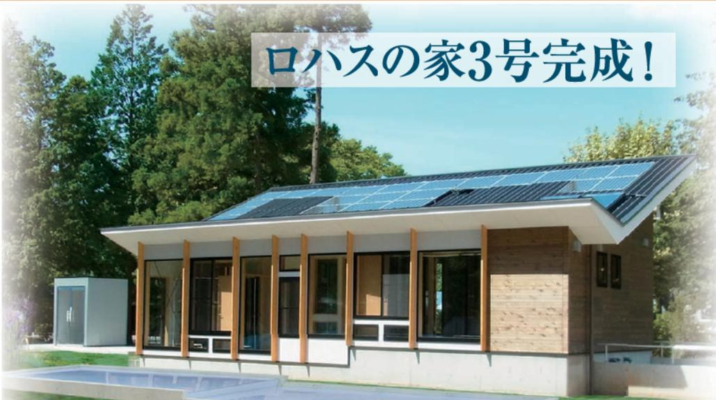
ロハスの家研究プロジェクトの一環として、平成23年11月「ロハスの家3号」が完成しました。ロハスの家1・2号で追求してきた、「熱エネルギー自立」と「電気エネルギー自立」に加え、3号では生活用水を自給する「自立共生の水確保」を新たな研究目標に掲げています。自然との共生をより意識した「パッシブデザイン」のデザインコンセプトも導入し、実際の住居に近い実験装置になりました。東日本大震災以来、再生可能エネルギーへの転換が叫ばれる中、「ロハスの家」の研究がますます注目を集めています。「ロハスの家3号」の最新の実験設備とこれから進められる研究内容について紹介しましょう。
