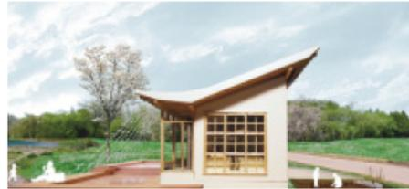
太陽光発電や太陽熱収集システムはもちろん、地中熱を採取するクール&ヒートチューブを利用した冷暖房、水の熱容量の大きさを利用したウォーターウォールによる冷暖房、家の断面形状を活かした空気循環システムなど、さまざまな要素技術を統合して造られています。また、バタフライ屋根で得られた雨水を集水して貯水・処理まで行う水自給システムも組み込まれています。まさに太陽・風・雨などを利用した自然との共生を図ったパッシブ住宅です。
