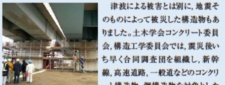
津波による被害とは別に、地震そのものによって被災した構造物もありました。土木学会コンクリート委員会、構造工学委員会では、震災後いち早く合同調査團を組織し、新幹線、高速道路、一般道などのコンクリート構造物、鋼構造物を対象とした被害調査を行いました。土木工学科岩城一郎教授も調査團の一員として調査にあたりました。3月25日から4月1日までの連続8日にわたり、岩手県・宮城県・福島県の36地点で行われた調査により、次のようなことがわかつりました。「地震の規模の割に、構造物の被害は比較的小なかったと思われます。これは阪神・淡路大震災や中越地震を教訓に、大地震が起きた際に損傷する危険度の高い高架橋の柱や橋脚の部分から優先して耐震補強を進めてきた効果の表れです。補強が間に合わなかった箇所での損傷はありましたが、それも早期に復旧できる程度のもので甚大な被害には及びませんでした」と岩城教授は被害状況について説明しています。また、これまでの震災から得た損傷した構
