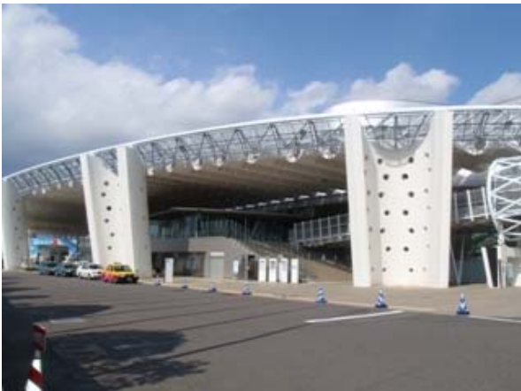
図-6.1 コンベンション施設 「ふくしまビックパレット」
