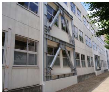
図-6.10 1号館の耐震補強
