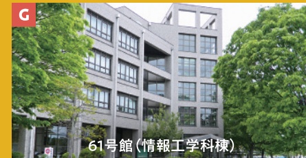
61号館(情報工学科棟) 情報工学科の中心となる校舎。研究室をはじめ演習用計算機室や自習スペースなどを備えています。
