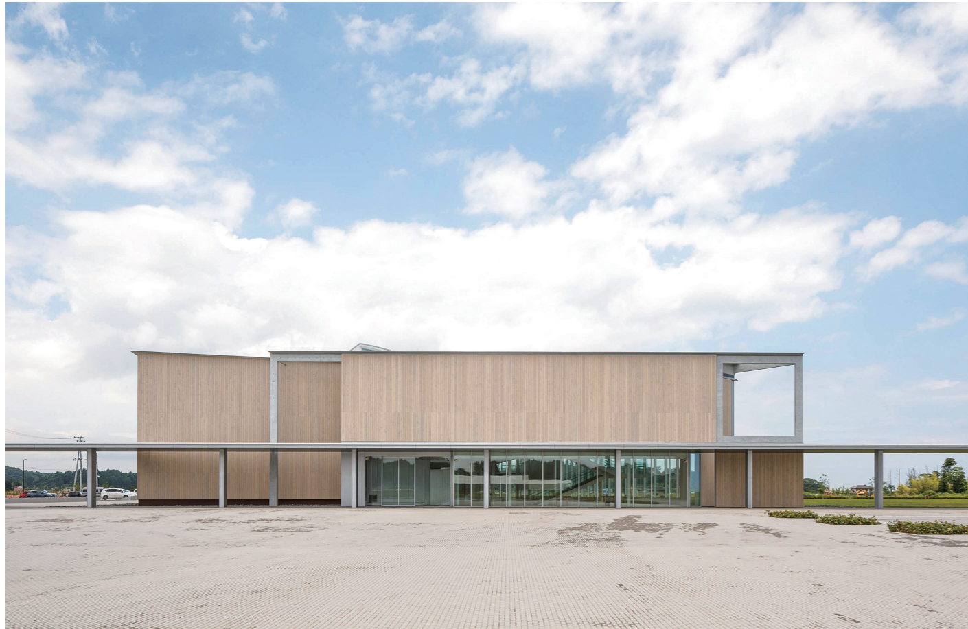
南側エントランス外観
