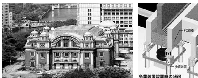
免震装置設置時の状況
