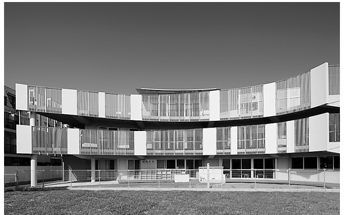
写真2 園庭側から見たバルコニーのルーバー
