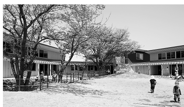
3 園庭と命の広場を結ぶコンクリートの階段ブリッジ
