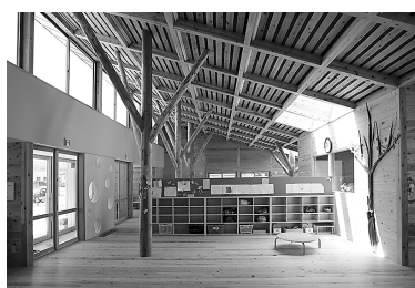
2 丸太の方杖付柱と格子梁が支える保育室
