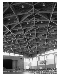
ダボ重ね梁工法の体育館
