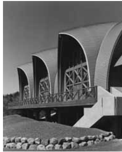
山の村多目的ホール外観
