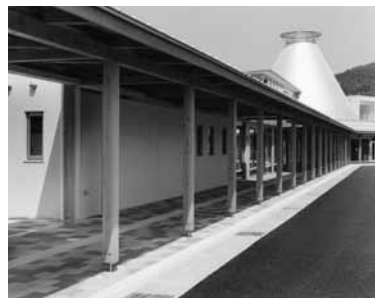
塙道の駅外観
