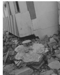
写真9(左): 伝統的な組積造家屋(壁は自然石を粘土モルタルで固めただけで、屋根は木造である。Bhujにて)
