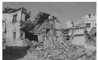
写真12: 組積造の住宅倒壊。Bhujにて
