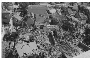
写真11: 建物の屋上から見た地震(三角屋根の伝統的な組積造家屋が大被害を受けている)の対し、RC屋根の新しい組積造は比較的被害が小さい。Bhujにて
