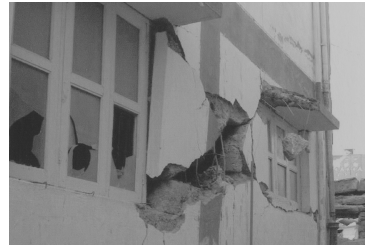
写真7(左): 伝統的な組積造の1階部分が崩壊した家屋(増築した2階組積造の損傷は小さい。Bhujにて)
