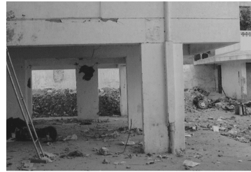
写真6: 写真3と同じ建物の1階にある短柱の破壊
