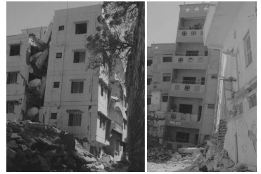
写真3(左): 5階RC造・ピロティの崩壊(手前の棟のピロティのみ生き残り、左と奥の棟のピロティが崩壊。Bhujにて)
