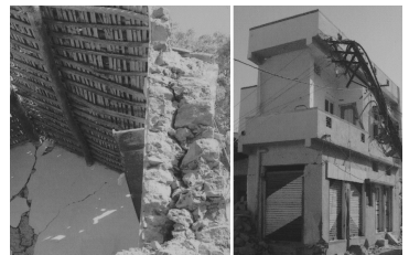
写真10(右): RCの床と屋根を持つ組積造家屋(RCによる水平面の拘束により抵抗力ははずっと強い。Bhujにて)
