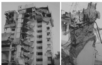
写真1(左): Mini Complex(写真に見えない高層アパートと同タイプの高層棟が手前にあったが、完全に倒壊した) 写真2(右): 倒壊した高層アパートの1階の様子
