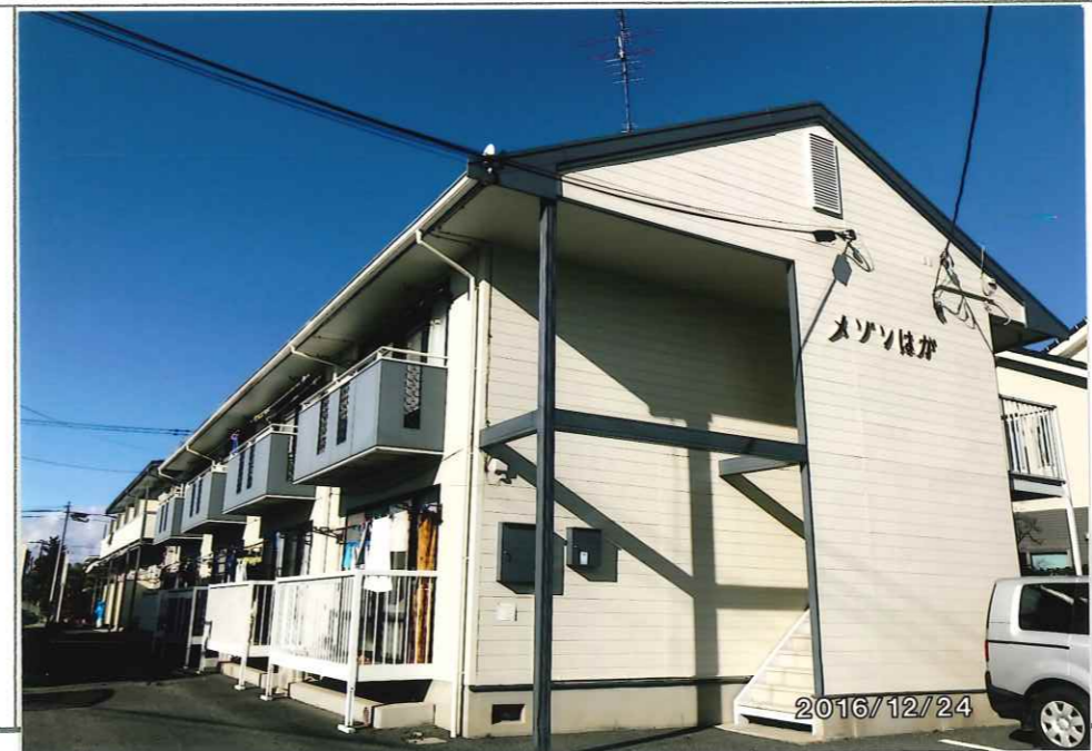
P R 欄 (外壁等の写真を貼付)
