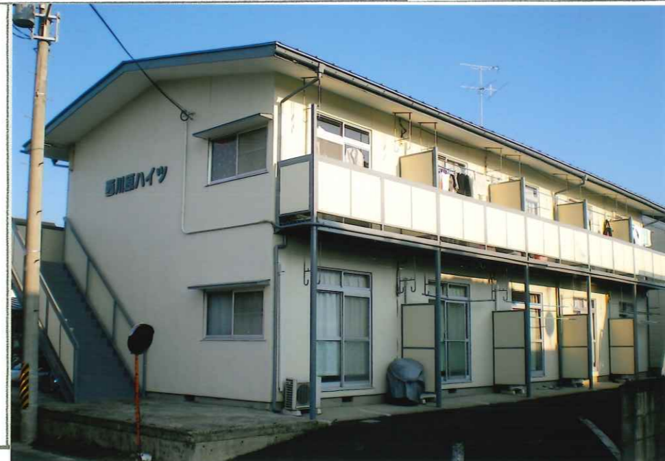
P R 欄 (外壁等の写真を貼付)
