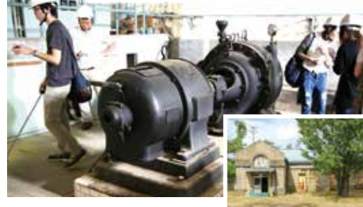
郡山市逢瀬川第一取水場ポンプ室
