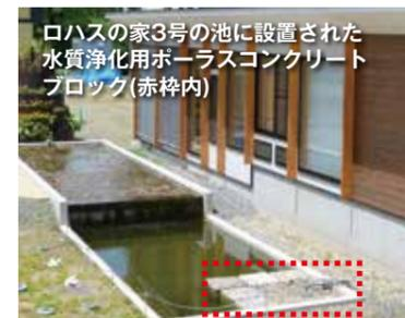
ロハスの家3号の池に設置された水質浄化用ポーラスコンクリートブロック(赤枠内)
