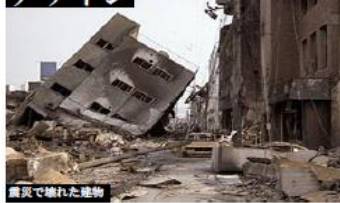
震災で壊れた建物
