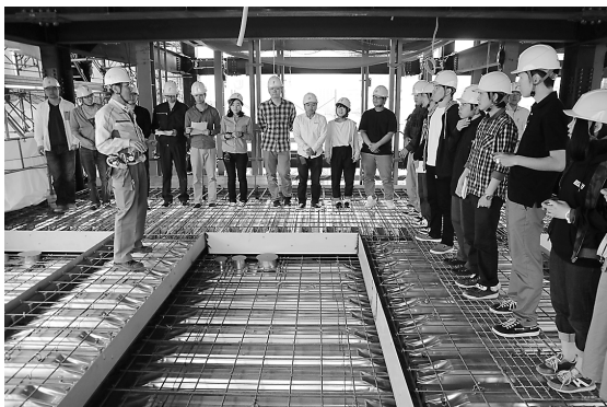
床コンクリート打設前の9階にて説明を受ける
