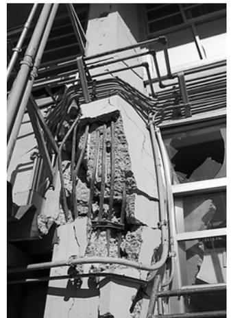
写真-5 剪断破壊した旧校舎柱
