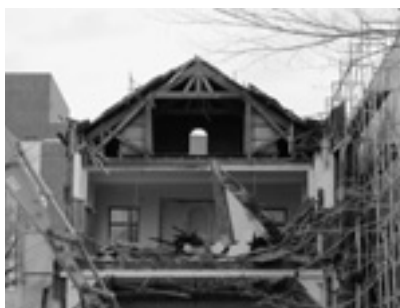
解体中の「旧ノートルダム修道院」 (2012年1月筆者撮影)
