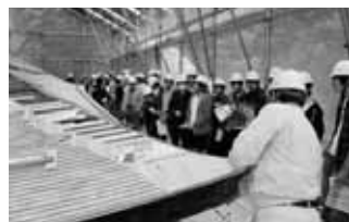
屋根の葺き替え現場
