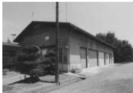
写真1 農業高校収納調整室
