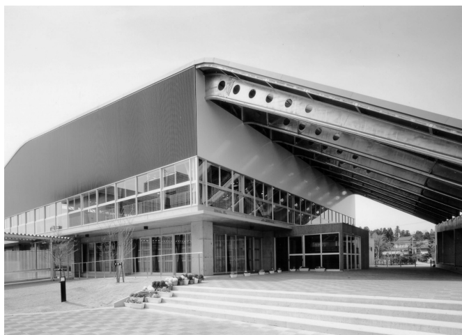
南側外観：既存昇降口からアプローチプラザを見る
