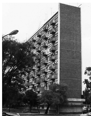
地震直後（隣棟）
