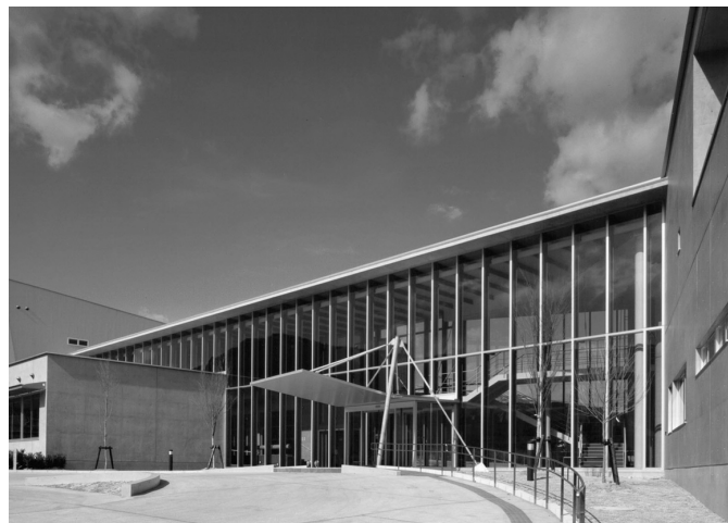
管理教育棟：正面入口付近パッサージュの様子
