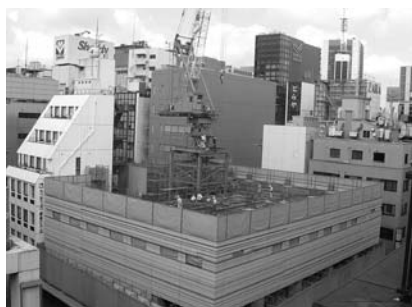
都内：某新築工事
