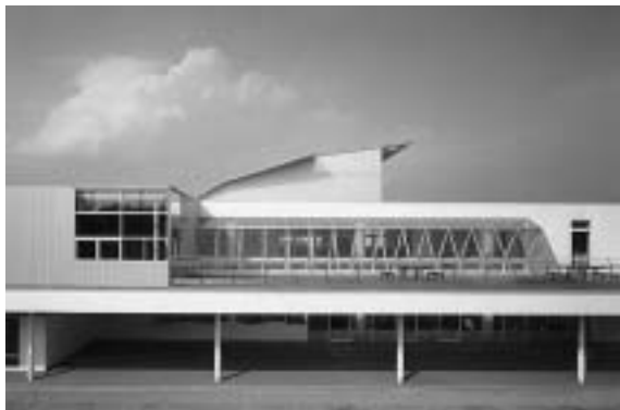
1階小学部の送迎車用ピロティをみる
